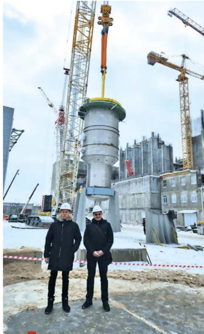
Процесс кантования корпуса реактора
